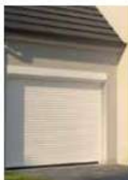
Pose en tunnel extérieure
