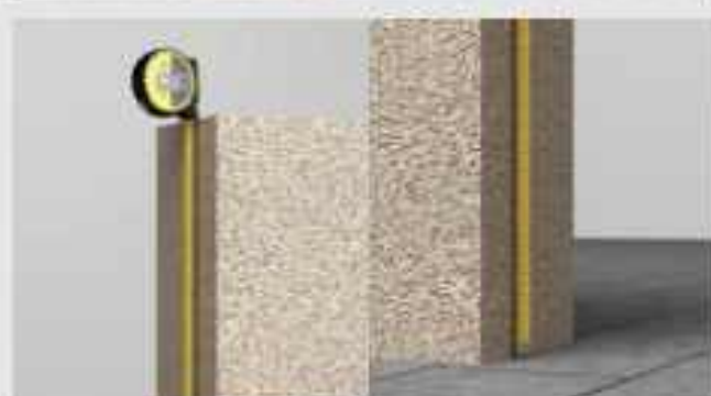
6 Prendre la hauteur des 2 piliers, retenir la plus petite mesure et déduire 10cm pour la mise en place des éléments de guidage / des gonds et cache-gond. Measure the height of both pillars. Consider the smallest height and deduct 10 cm so there will be necessary to place the sliding elements (the hinges and hinge cover).
